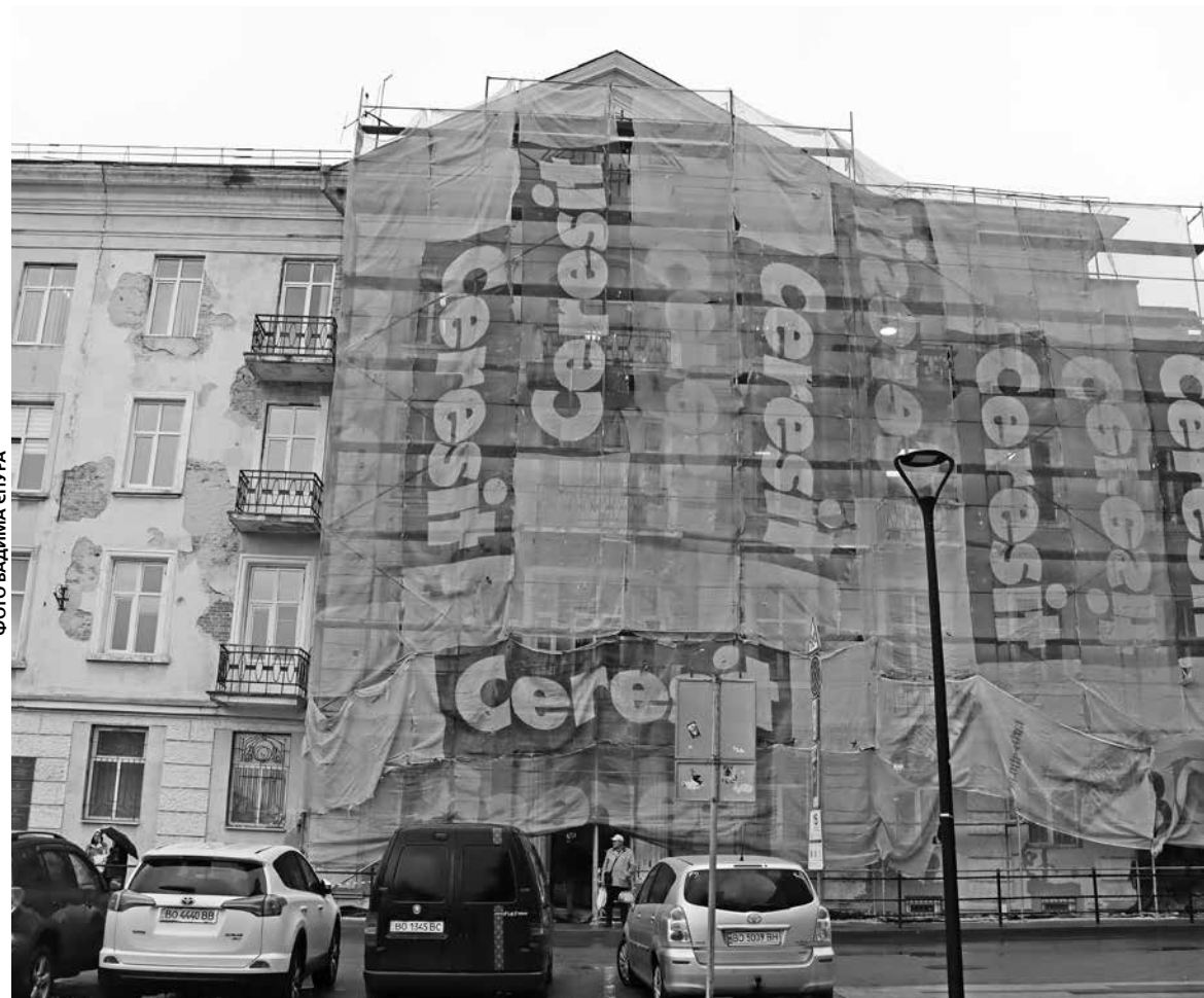
Частину фасаду вже оновили, але її приховує риштування. Стіни будуть світлого жовтого кольору
