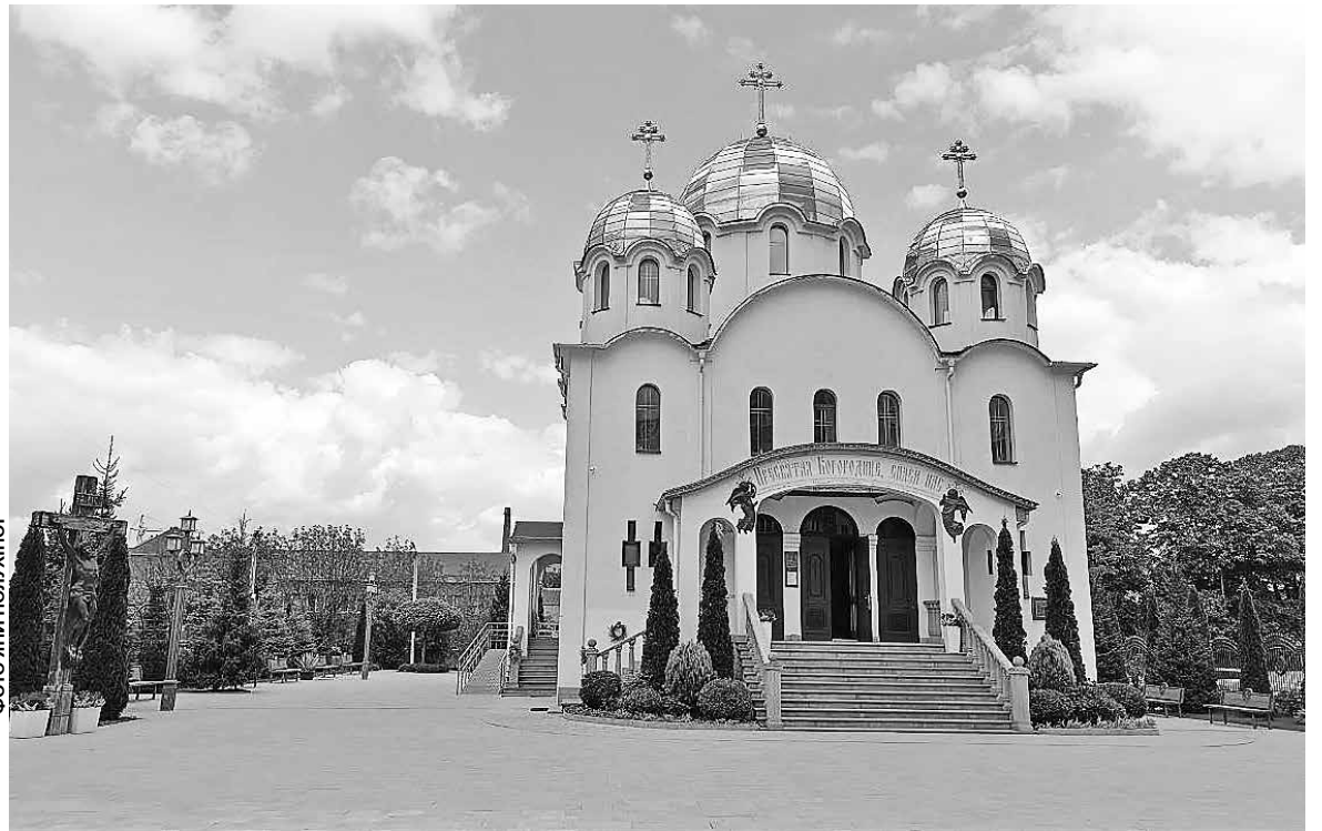
Нове будівництво розпочали на Київській, біля храму Різдва Пресвятої Богородиці. Будівельного паспорта на об'єкті станом на 16 травня немає
